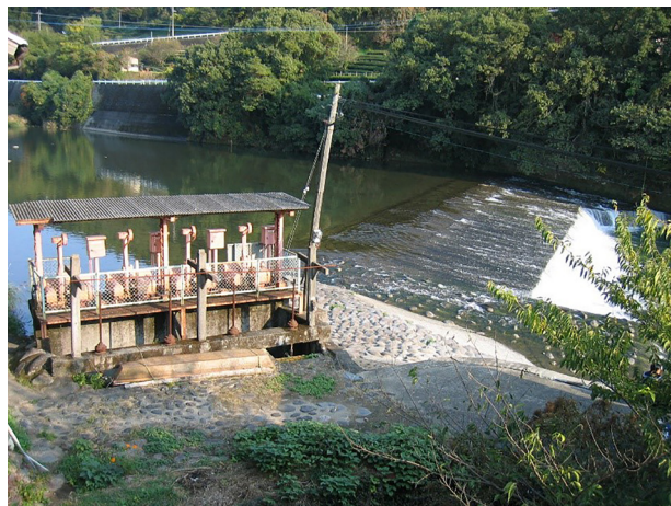
黒木堰と廻水路の樋門
