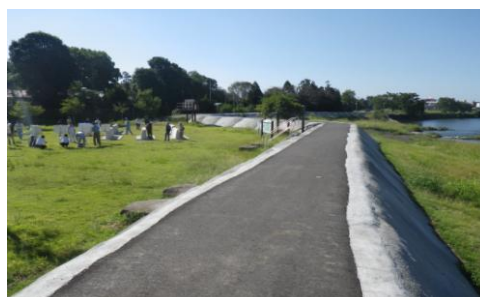
白川下流・小礫水辺緑地一帯の仮堤防
