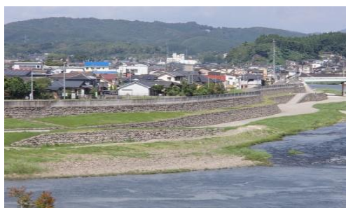
川内川虎居地区（激特による整備後の堤防）
