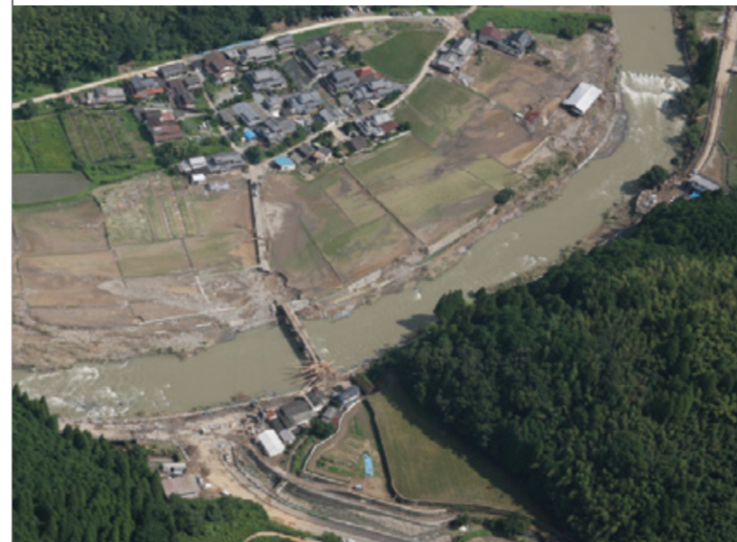
宮ヶ原橋周辺の状況 (榎大成ジオテック)
