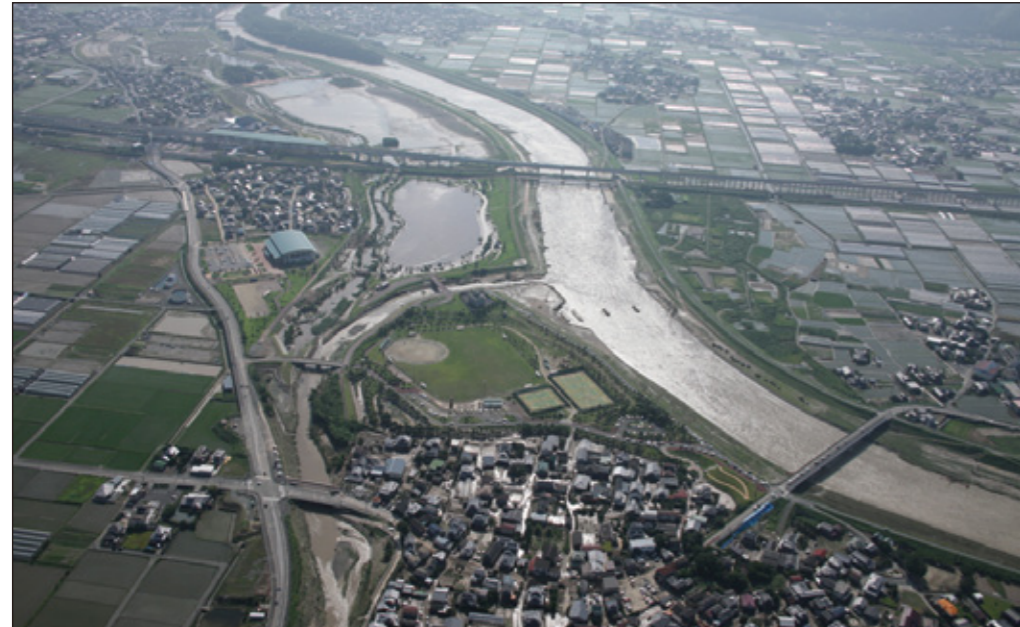
新幹線船小屋駅周辺・筑後広域公園広域公園は大きな水瓶 (大成ジオテック株)
