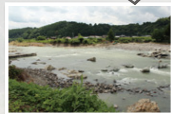
消失後の唐ノ瀬堰(馬場)
