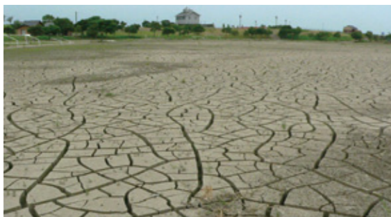
広域公園遊水池グランドでは最大20cmの土砂が堆積した 2012.8.9 (木庭)
