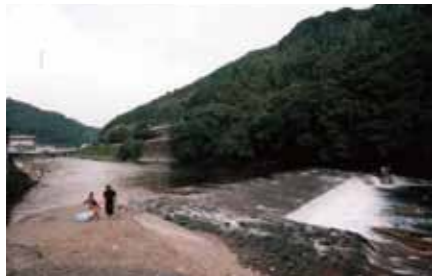
黒木堰。矢部川右岸下流から
