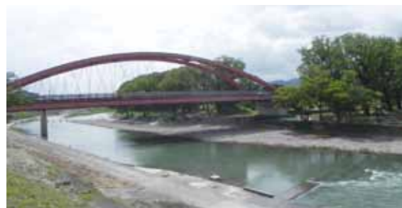
「夏休みになったのにまだ工事が終わらず 使えない船小屋中ノ島公園」 …例年大賑わいの水泳場には誰もいない。
