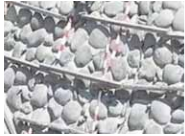
コンクリート玉石乱積護岸
